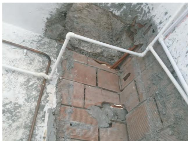
*Paroi réservée aux boisseaux perméable à l'air*
