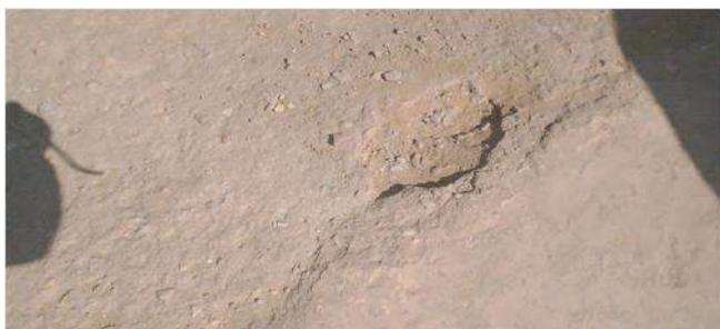
**Un sondage qui illustre la couche de mortier batard réalisée sur une couche d'isolation en sable**
