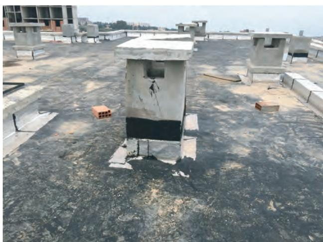
*Hauteur des orifices des conduits non conforme*
