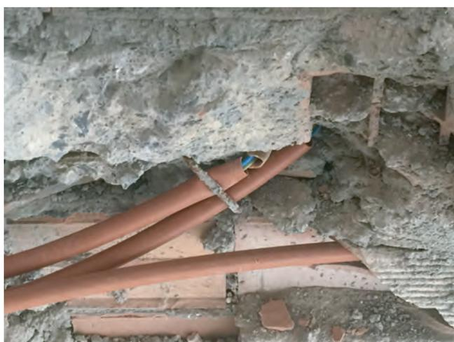
*Câbles électriques dans les conduits de fumée*
