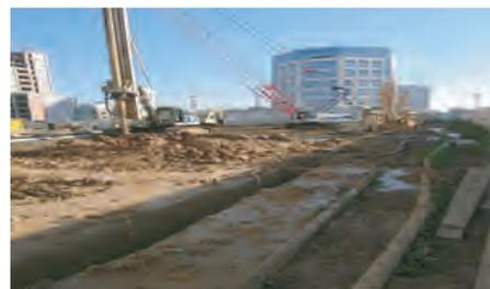
**Etape 2 : Réalisation des panneaux de la paroi et excavation de la fouille**
